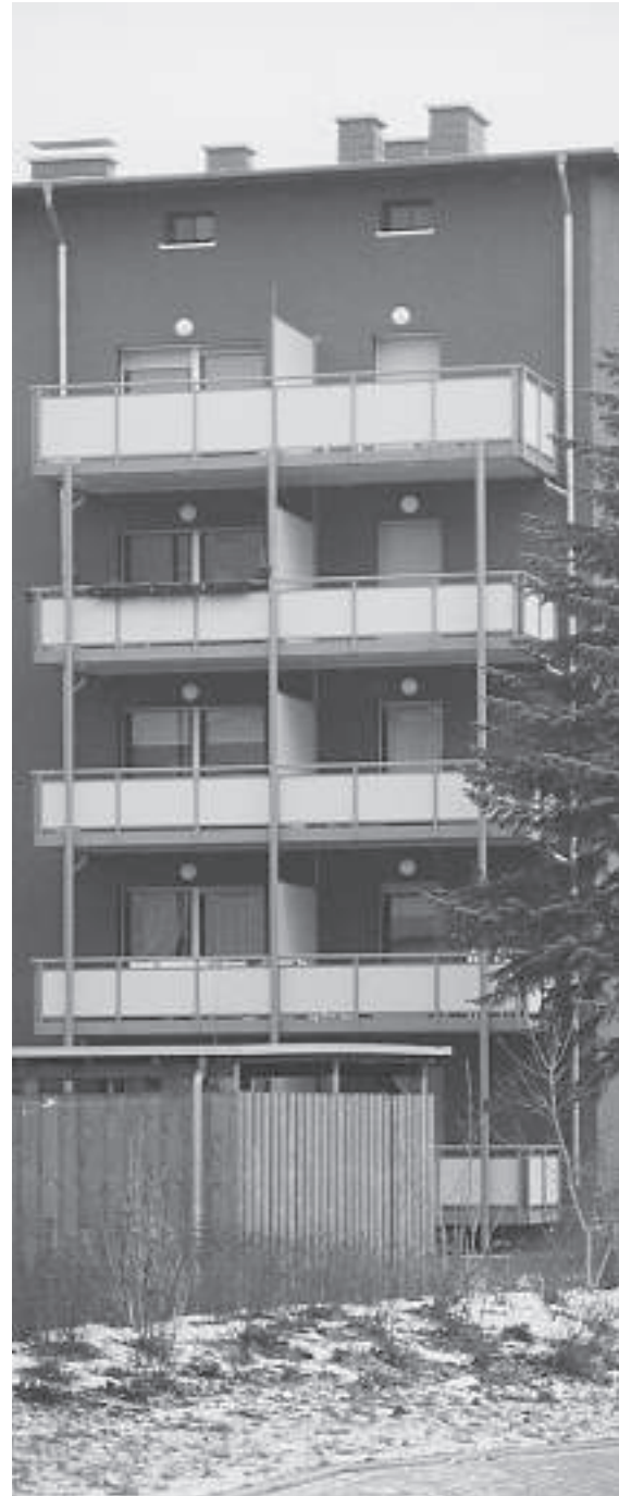
Kloschinskystraße mit neuen Balkonen
