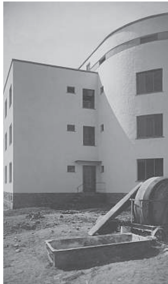
Zeughausstraße 27 (noch mit Flachdach)
