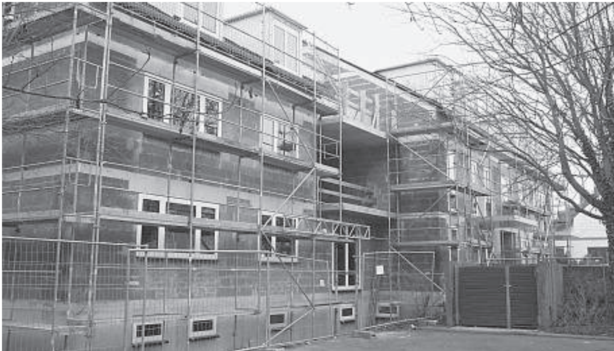
Benediktinerstraße 44b - (9 Wohnungen) im Rohbau
