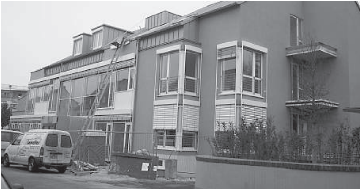
Benediktinerstraße 44, 44a – neues Büro und 4 Mietwohnungen fast fertiggestellt.
