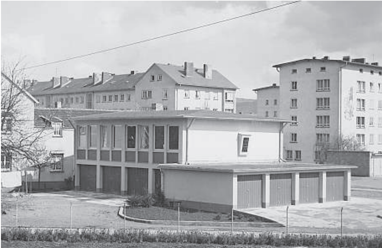
Büro in der Kloschinskystraße 82 (bis 2006)
