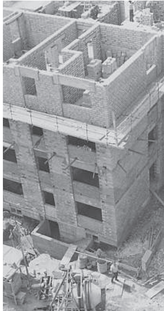
Baustelle Am Weidengraben
